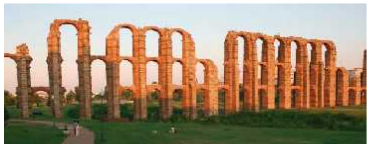
Acueducto de los Milagros
