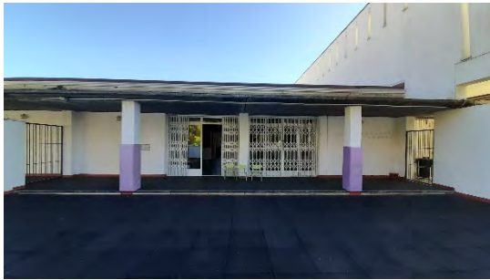
Detalle del aula, desde el patio
