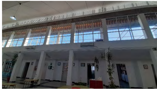
Detalle de las aberturas en la parte superior
