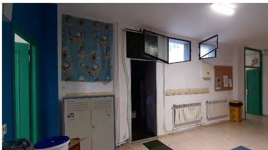
Ventanas del hall. Aula a la izquierda
